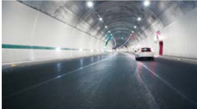
Base Tunnel Variante di Valico - A1 Motorway Italy
